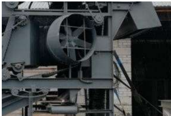
Foto 10. Saída de ar externa ( duto) da ventilação
